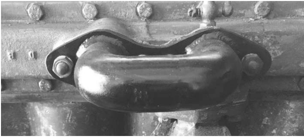
Fig.8 製作したバイパス・パイプ
